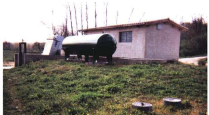
Un ballon hydrofort, d'un volume total de 9 000 litres, assure une protection anti-bélier et limite le nombre de démarriages dans les petits débits ( $< 50 \text{ m}^3/\text{h}$ ).
